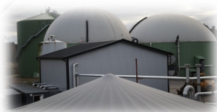
Overview of biogas plant in Värgråda-Herrijunga Biogas AB in Värgråda, Sweden
